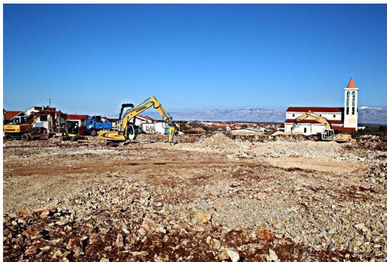
Slika 10. – Osnovna škola Novi Bokanjac u izgradnji – prosinac 2019.
