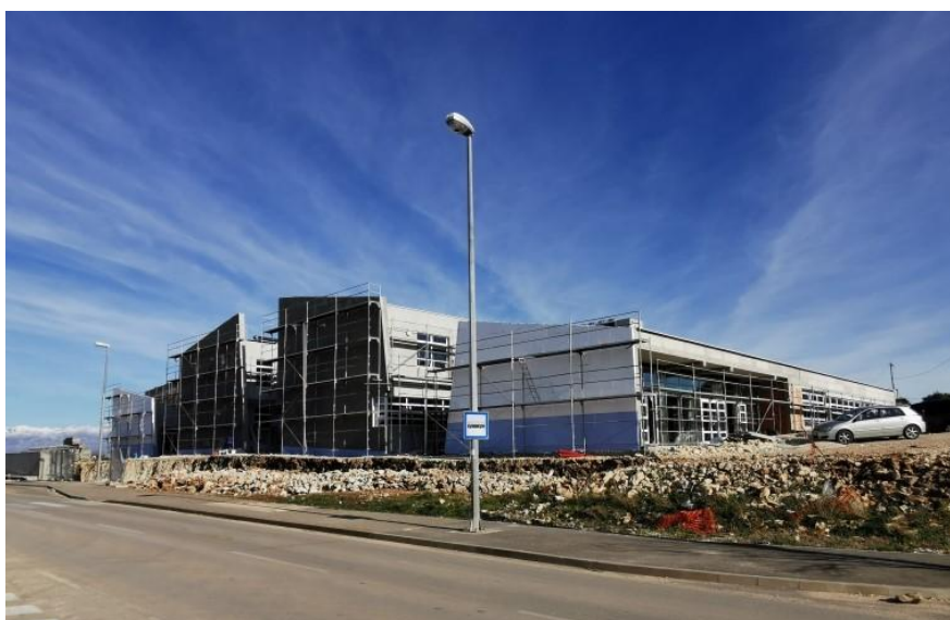
Slika 11. – Osnovna škola Novi Bokanjac u izgradnji – rujan 2020.
